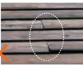
底が短い場合は、外壁の反りを押さえる為に継ぎ目の箇所を釘で打つ等、
