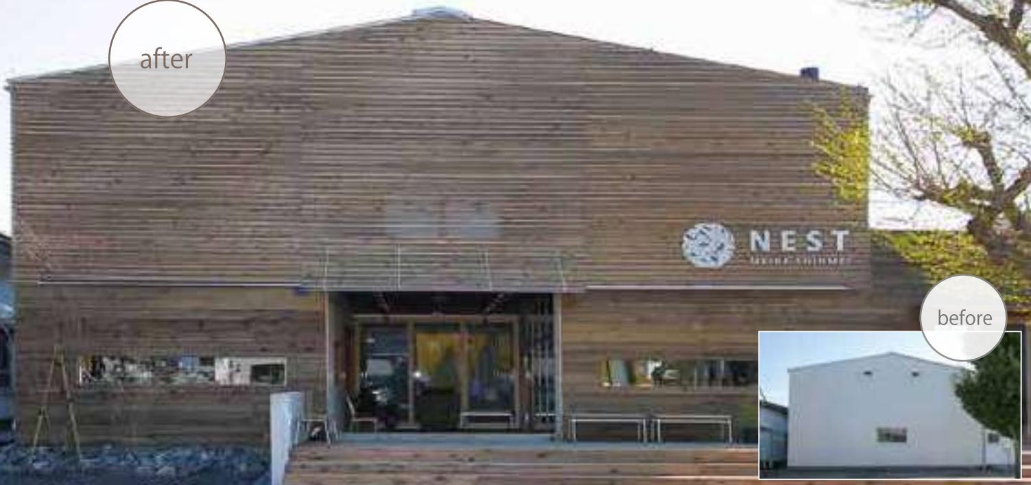
2021年施工 元クロネコヤマトの倉庫を商業施設へリノベーション/ 設計:石田伸一建築設計事務所(以下 SIA inc.) UC材(魚沼杉+ウッドロングエコ塗装)を全面に使用
