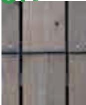
継ぎ手と継ぎ手の間は10mm程度あける
