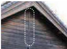
多雨地域で底が短い外壁に、横継ぎ材をいたした事例。
