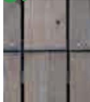
継ぎ手と継ぎ手の間は10mm程度あける
