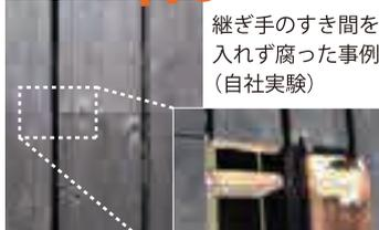
継ぎ手のすき間を入れず腐った事例(自社実験)
