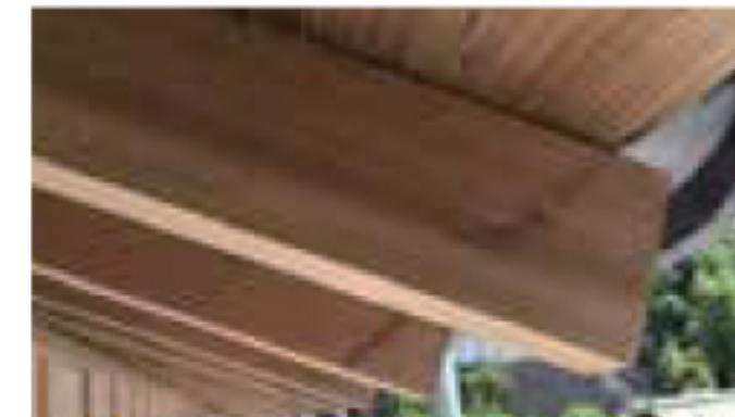
金属製の雨樋を通った雨と木材が化学反応したシミ
